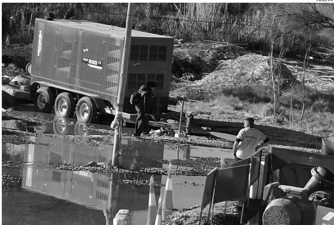
DESBORDES. Las aguas residuales afectan a habitantes de diversas zonas. Piden agua potable.
