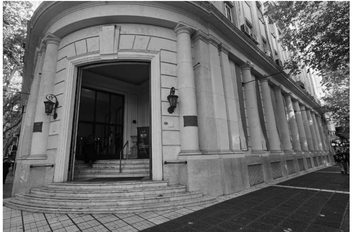
INNOVACIÓN. La reciente modernización permitió mejorar el sistema de recaudación y retomar el mercado.
