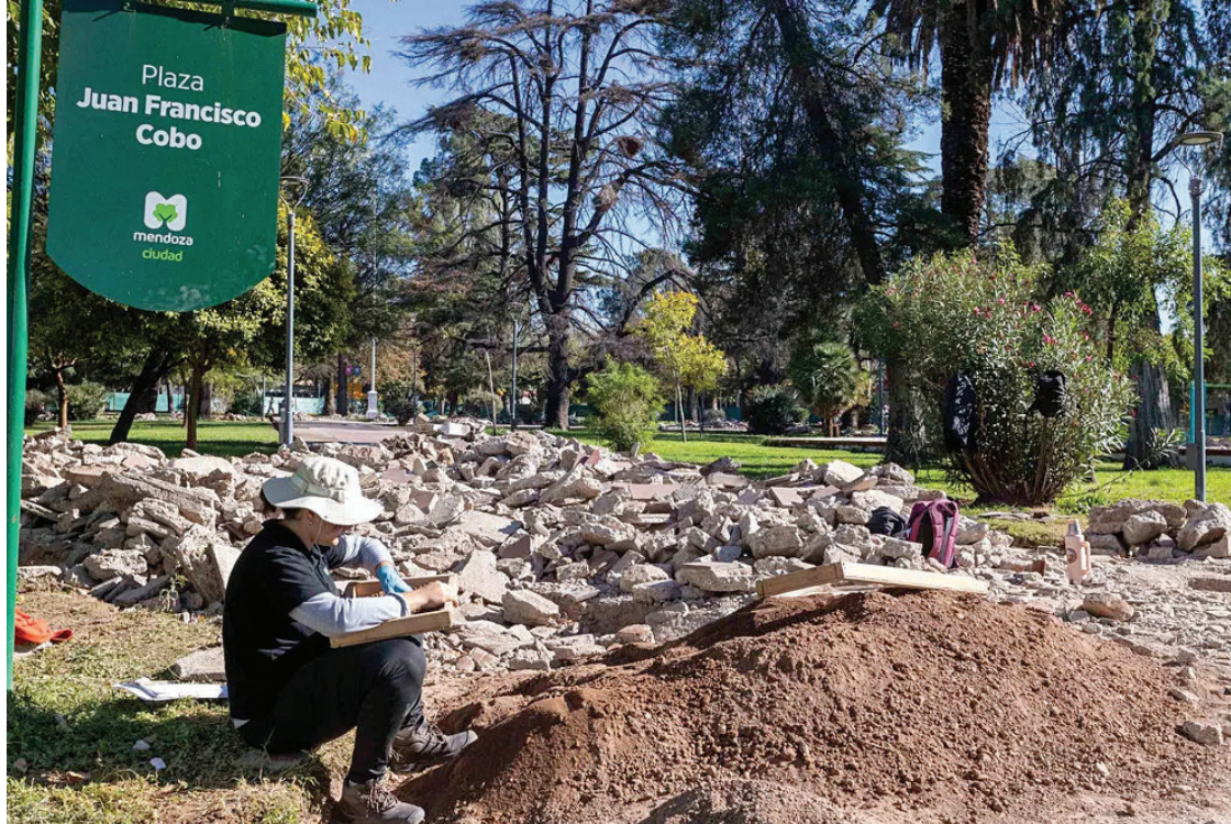
DESCUBRIMIENTO. Se encontraron estructuras demolidas, como pisos, arranques de muros y cimientos.
