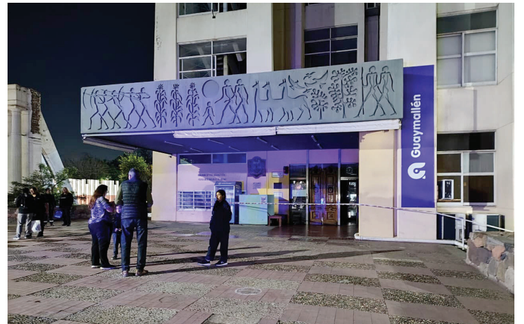
FUEGO. Las llamas afectaron el tercer piso del edificio municipal.
