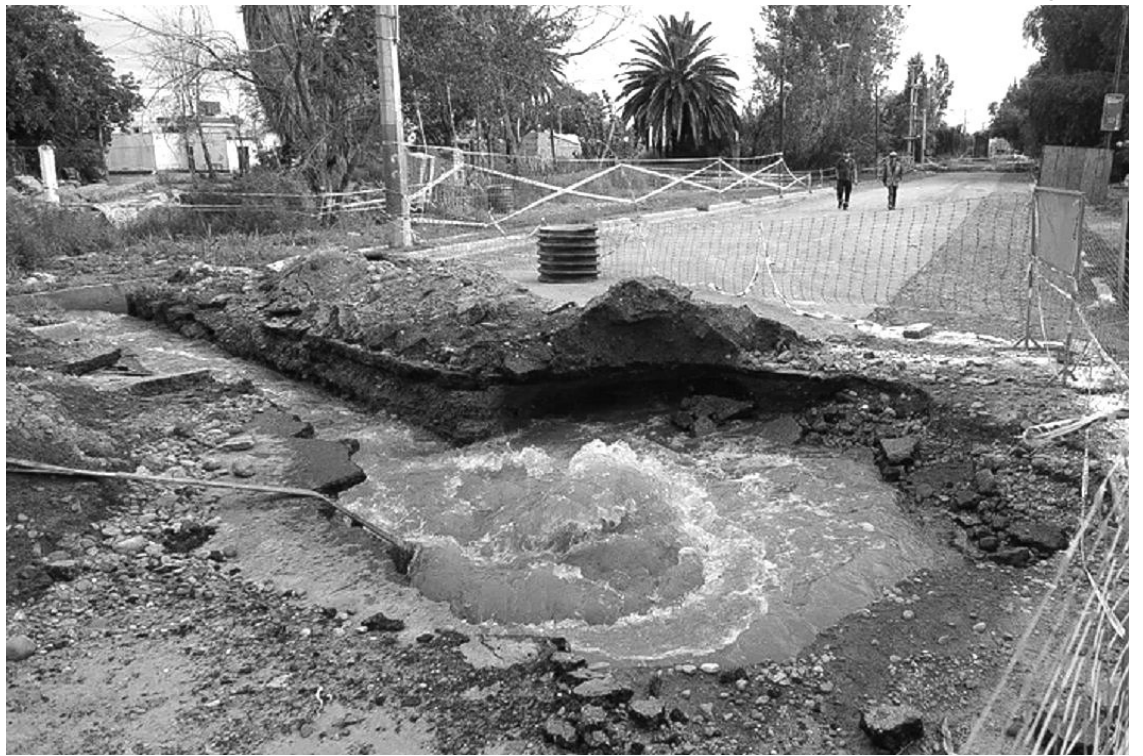
EMERGENCIA. El colapso de un colector cloacal afectó a tres distritos en Guaymallén.
