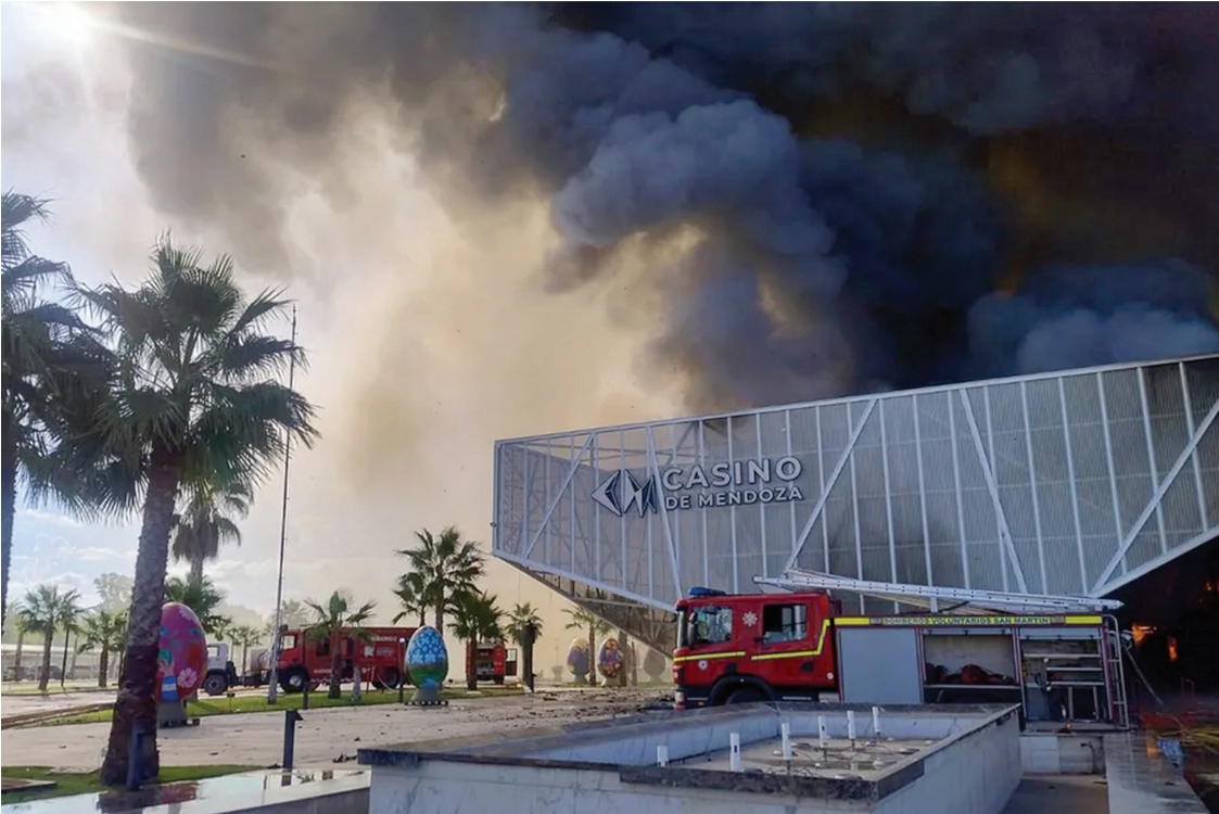
DENSO. Si bien el incendio generó una cortina espesa de humo y no hubo heridos, sí pérdidas totales.
