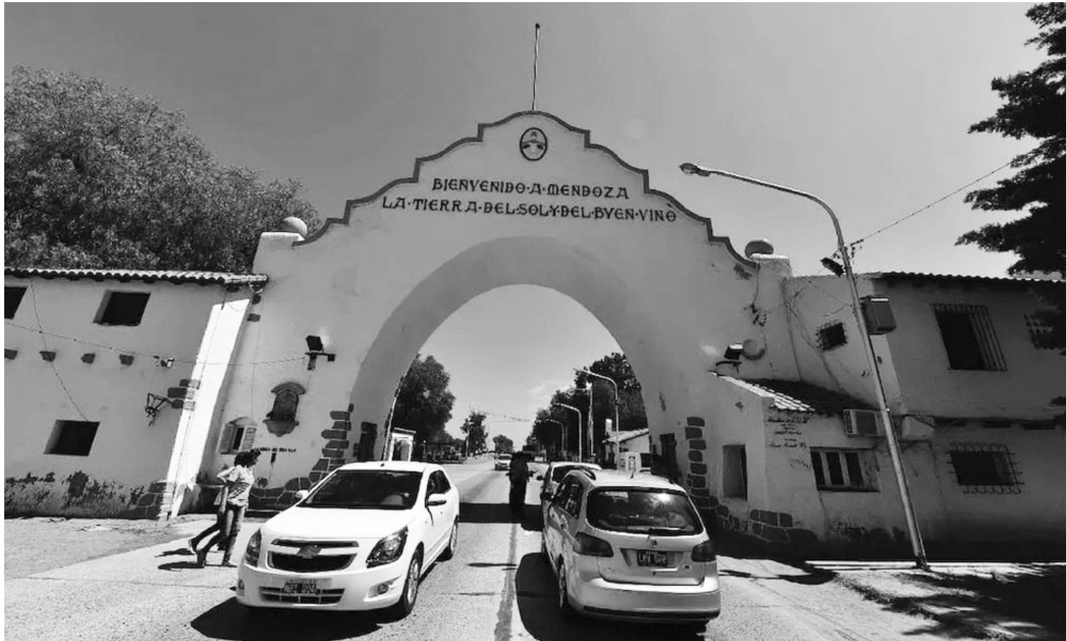
CORREDOR BIOCEÁNICO. La concesión abarca desde el Arco Desaguadero hasta el Cristo Redentor.
