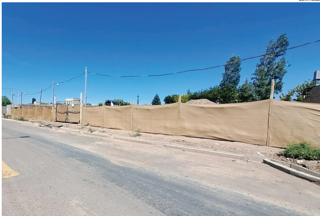
AVANCE. En diciembre, los vecinos comenzaron a observar trabajos en el terreno, que no tenía cartel de obra.
