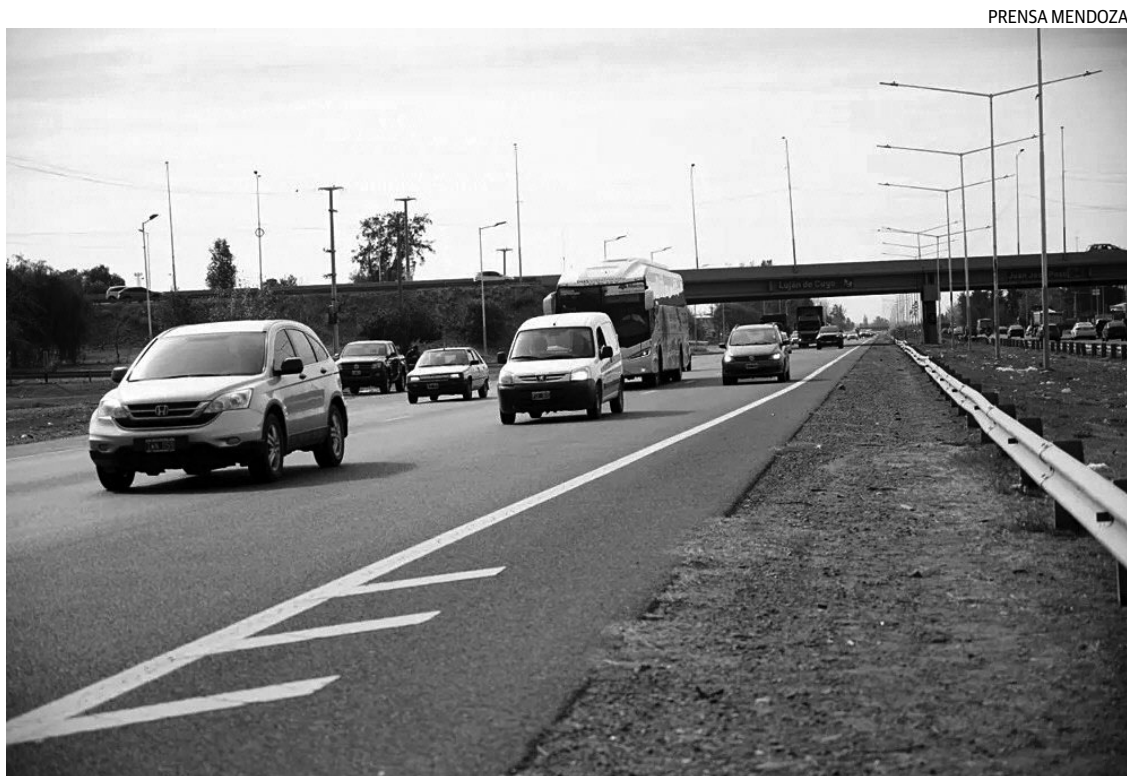
OBRAS. Avanza la licitación pública para las mejoras en el Acceso Sur.
