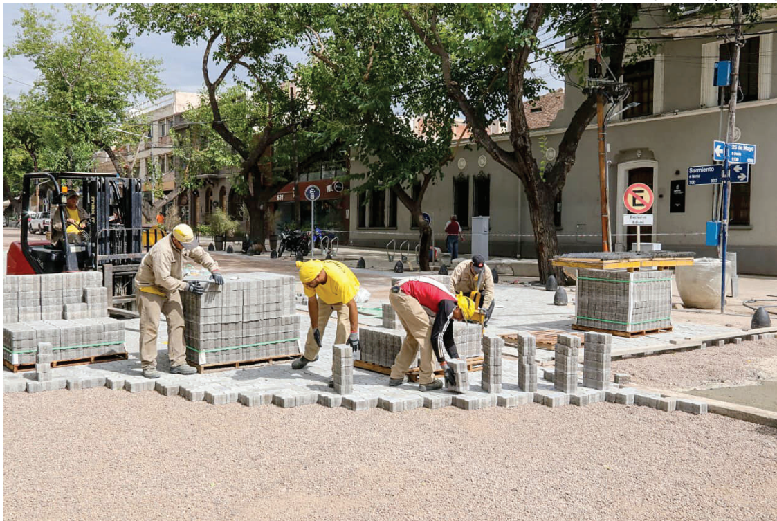
ESTRENO. La nueva calle está adoquinada. Además, se mejoraron rampas, acequias y se ampliaron veredas.
